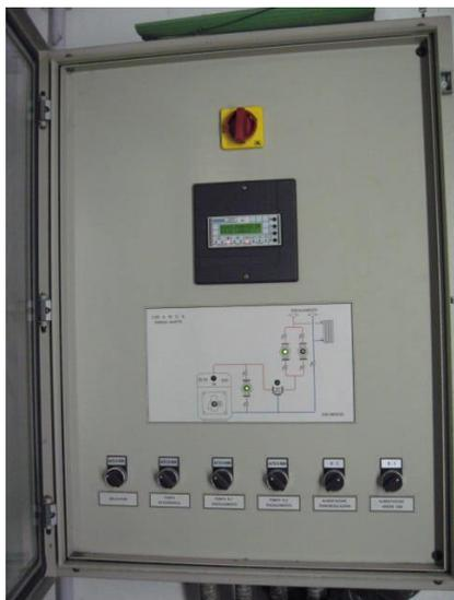
Figura 4.9 – Quadretto di regolazione caldaia murale Polizia Municipale
